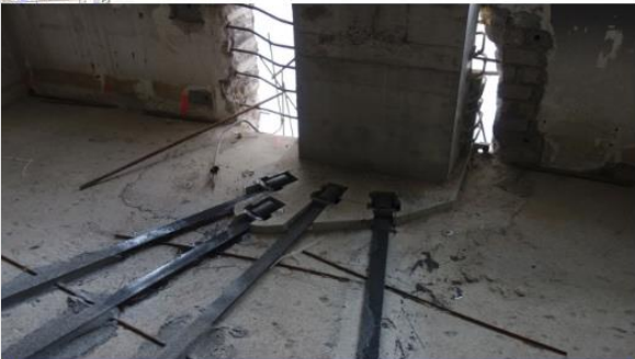
Fassadenanschluss Stahleinlageteil
