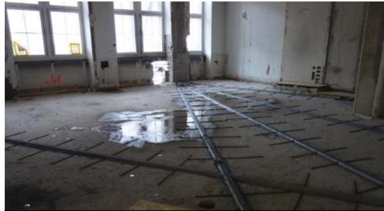
CFK-Lamellen vorgespannt auf 100kN
