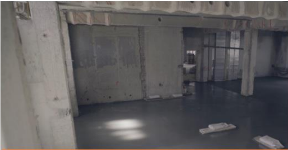
Scheibenertüchtigung 35mm Hochleistungsfasermörtel
